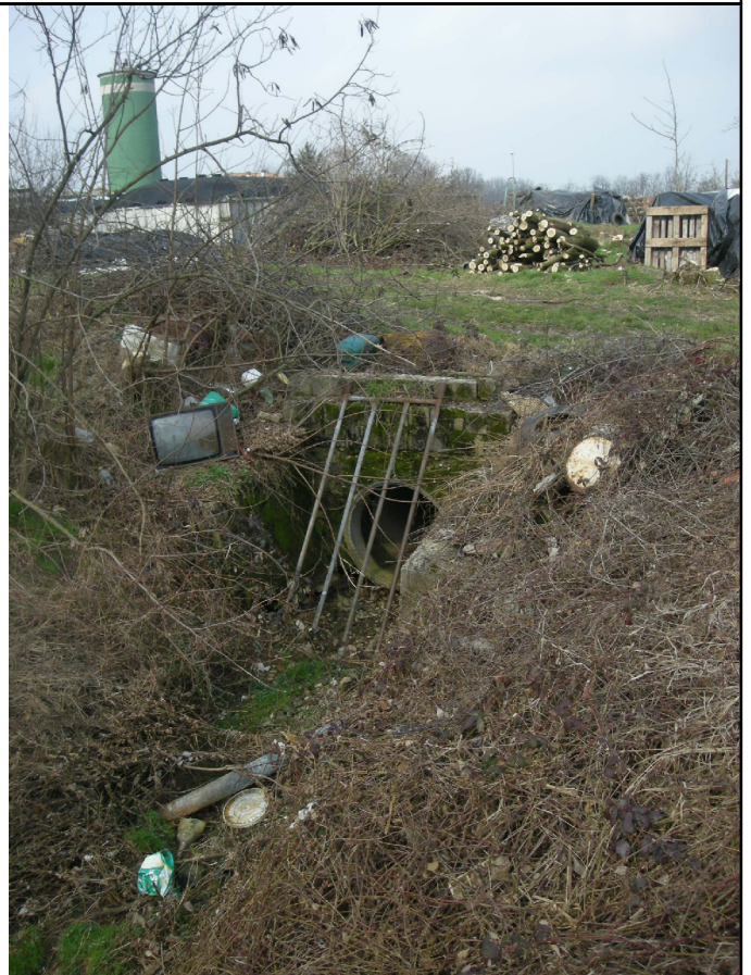
Foto 2 : Rio Riazza inizio tratto tombinato all'altezza di Castello Vecchio
