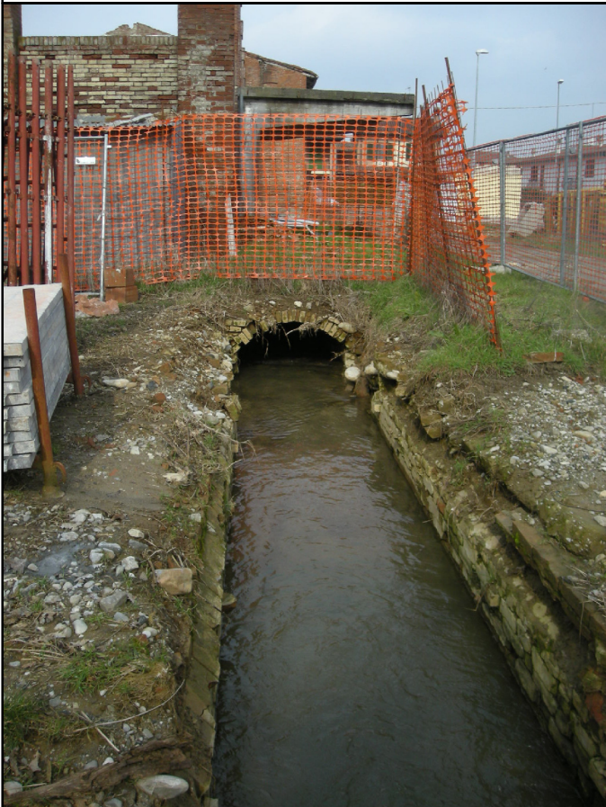
Foto 1 : Imbocco tratto tombinato del Rio Bertoncino all'ingresso nell'abitato di Turro
