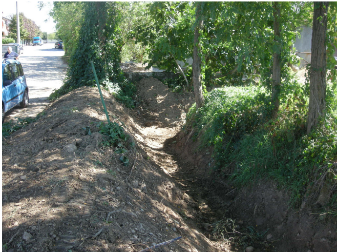
Foto 1 : Tratto del Rio Colombaia in corrispondenza di via Vescovi
