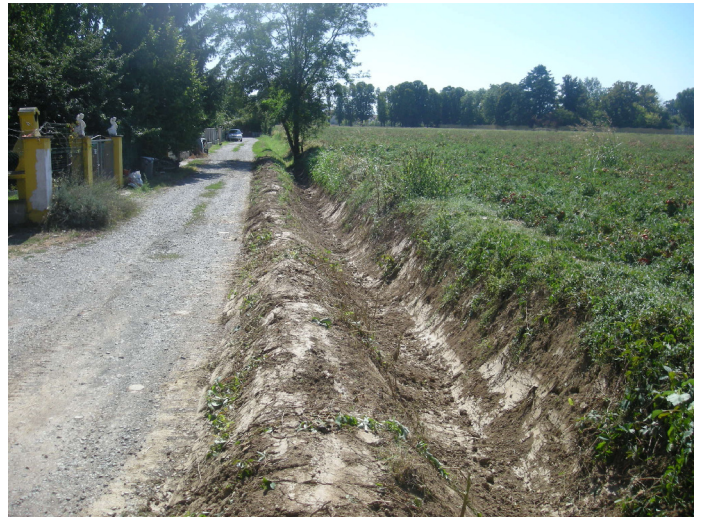
Foto 2 : Tratto di canale confluyente nel Rio Colombaia lungo via Vescovi
