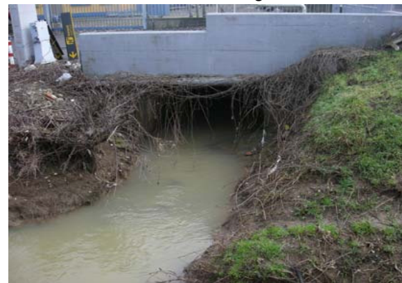
Foto 1 - Punto di ripresa lungo la SP564 in Loc.tà Casoni d Gariga
