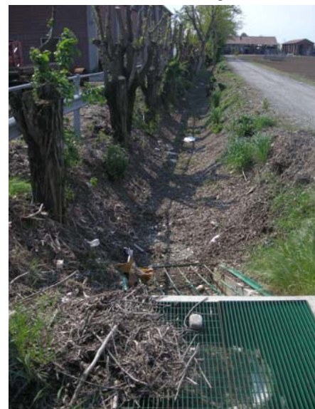
Foto 1 - Punto di ripresa nei pressi della Strada Comunale della Sarda
