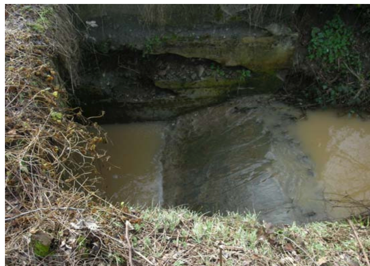
Foto 1 - Punto di ripresa all'ingresso dell'abitato di Gariga
