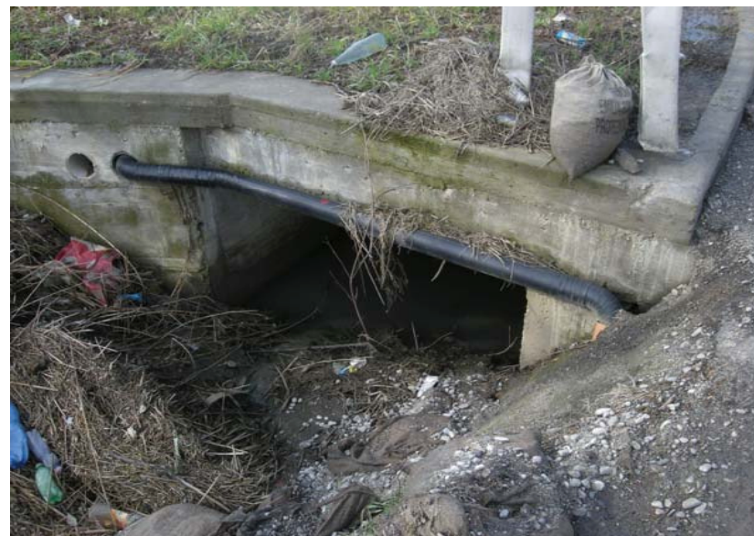
Foto 1 - Manufatto lungo la SP carpaneto in Loc.tà Crocetta
